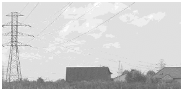
Rys. 6. Sieć elektroenergetyczna wysokiego napięcia
