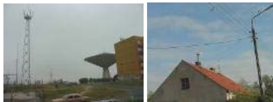
Rys. 15. Połączenie masztu antenowego stacji bazowej telefonii komórkowej i sieci elektroenergetycznej
